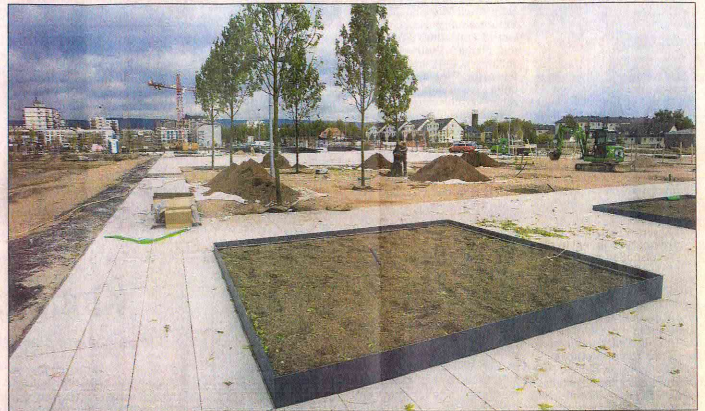
Der zentrale Quartiersplatz des 15 Hektar-Geländes, der Christa-Moering-Platz, wird angelegt.
