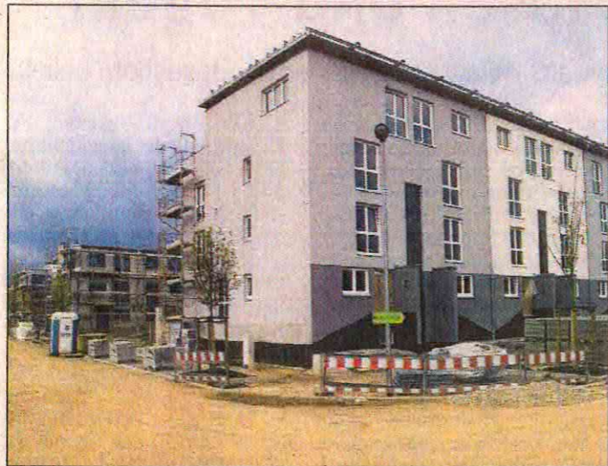
Erste Gebäude im Geschosswohnbau: Die NH Projektstadt will aber auch verschiedenartige Einfamilienhäuser errichten.
