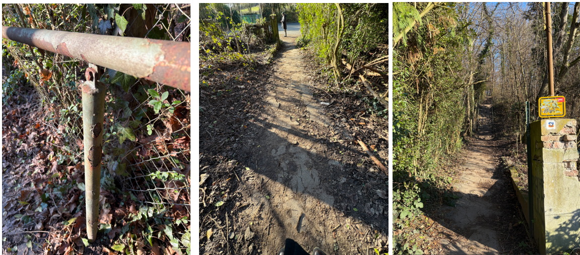
Treppengeländer, Gehweg und Gesamtansicht Aloys-Kunz-Weg, Stand 26.12.2025
