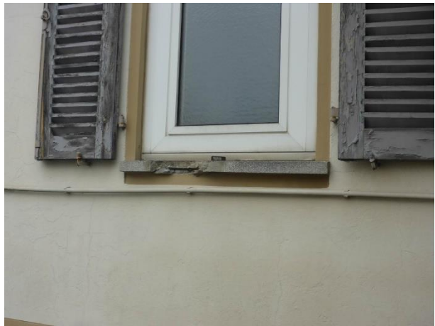
Abbildung 14 defekte Fensterbank
