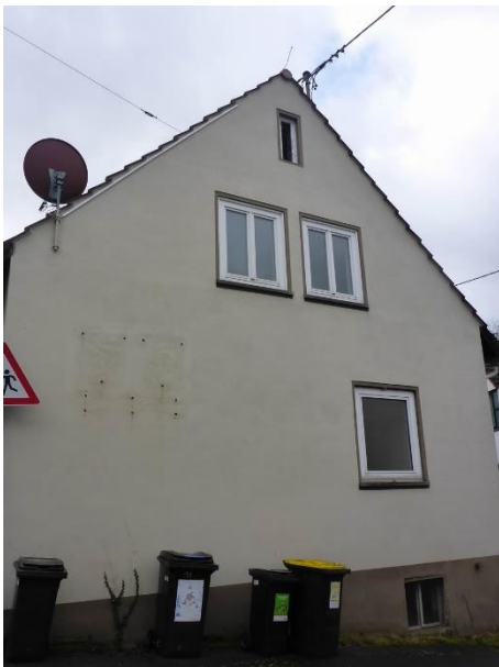
Abbildung 9 Ansicht von der Hauptstraße von Nord-Osten
