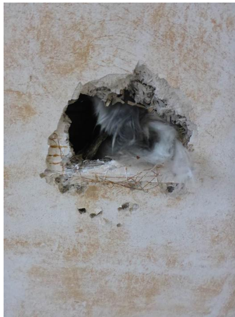
Abbildung 20 Schadstofffreilegung KMF
