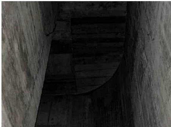
Stahlbetondecke mit Spuren von Brandresten
