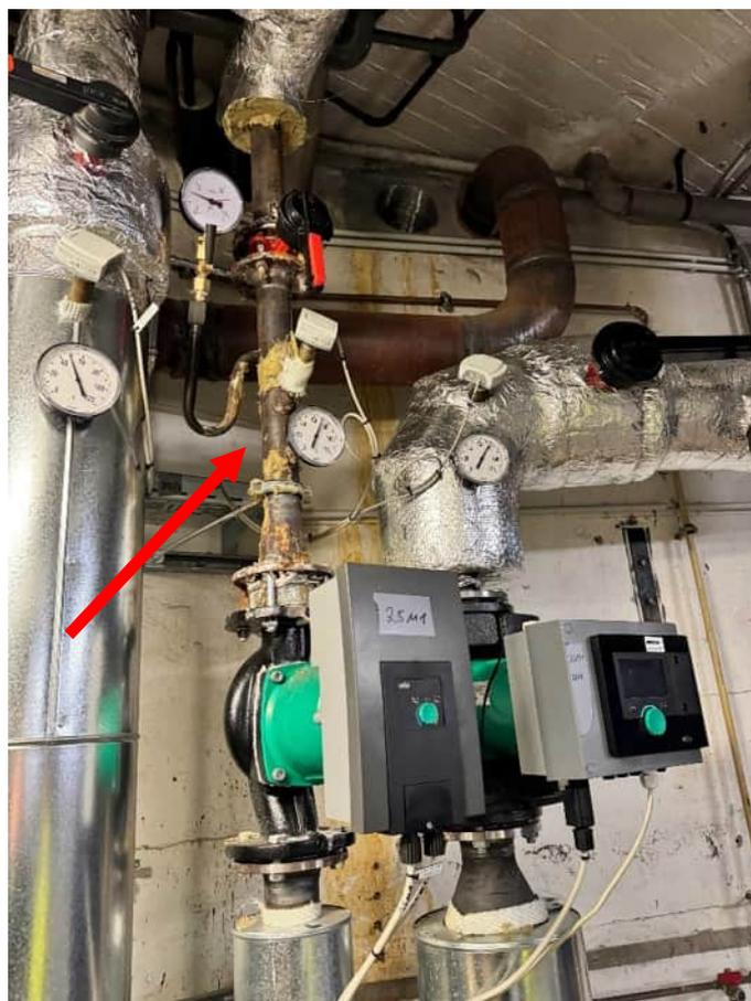
Foto vom 06.02.2024 – KG Heizzentrale - neuer HK-Verteiler – fehlende Dämmung
