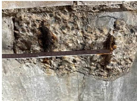
Gravierende Betonschäden am Stb.-Balken auf der gesamten Länge => ggf. Abstützung erf.
