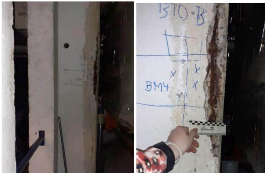
**Bild 35: Ansicht der Probe BM 5 („sanierte“ Hauptstütze in Achse 205 und 109)**
