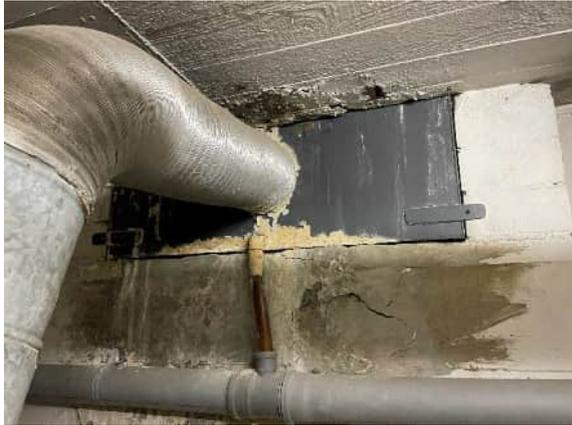
Zuluft-Aussparung mit mangelhafter Sanierung
