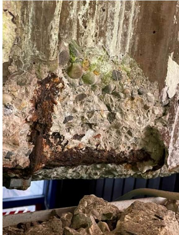
Gravierende Betonschäden am Stb.-Balken auf der gesamten Länge => ggf. Abstützung erf.
