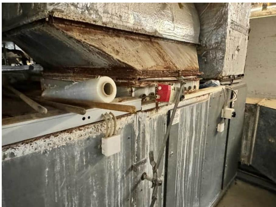
Foto vom 06.02.2024 – KG Technik – völlig korrodierte RLT-Anlage
