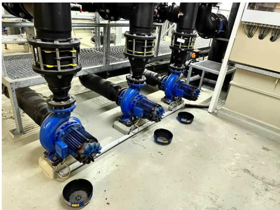
Foto vom 06.02.2024 – KG Technik – Filtratpumpen
