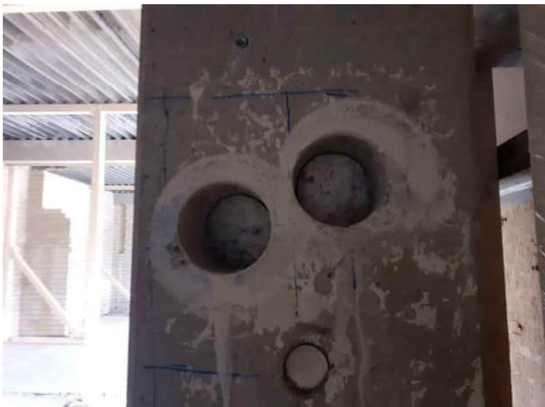
**Bild 28: Ansicht der Entnahmestelle des Bohrkerns 2 - Balken / Deckenrand**
