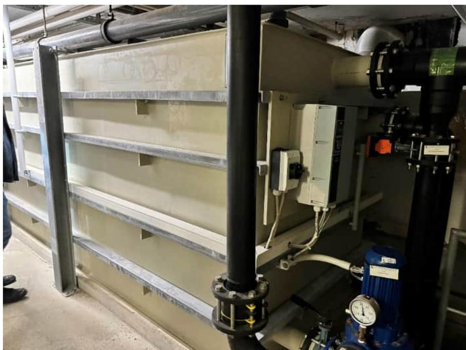
Foto vom 06.02.2024 – KG Beckenumgang – Rohwasser-Zwischenspeicher Planschbecken
