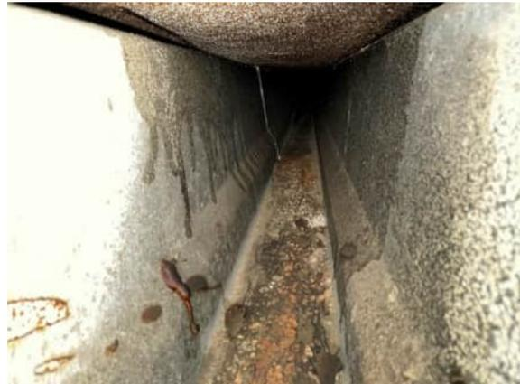
Ablagerungen u. Korrosion in einer Sicke
