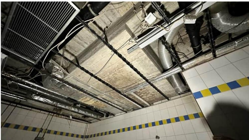
Foto vom 06.02.2024 – zurückgebaute Unterdecke
