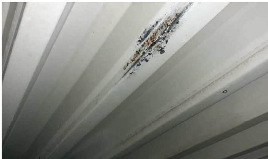
Es liegen keine Angaben zur Anzahl und der Lage der Spannbetonlizen vor. Augenscheinlich weist der Träger im Auflagerbereich ein T-Profil auf, in Feldmitte ist ein Doppel-T-Profil erkennbar. In Feldmitte sind runde Aussparungen im Steg ausgebildet. An einzelnen Stellen sind kleinere Durchdringungen (werksseitig hergestellt) vorhanden.
