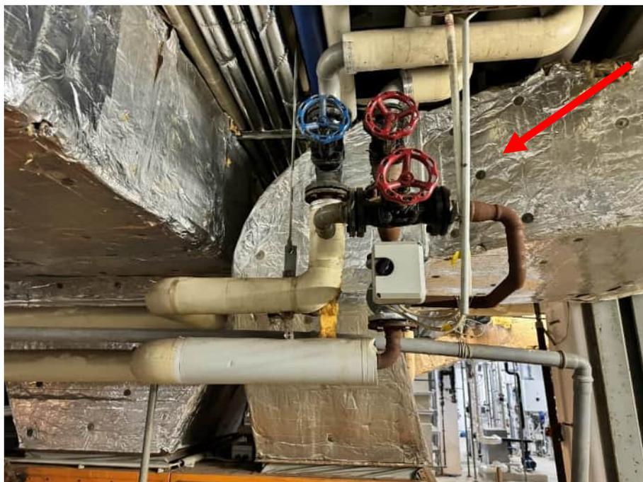
Foto vom 06.02.2024 – KG Technik – Korrodierte Heizungsleitungen, veraltete Armaturen, fehlende Dämmung
