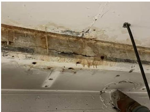
Rissbildung am Konsolaufleger Beckenkopf/ Beckenumgang und Schäden an der Decke
