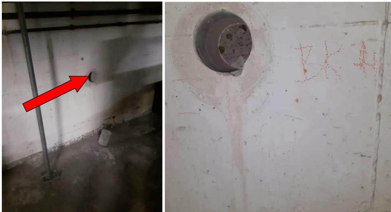
Die nachfolgenden Fotos zeigen die **Entnahmestellen der Chloridproben** vor bzw. nach der Entnahme der Bohrmehlproben:
