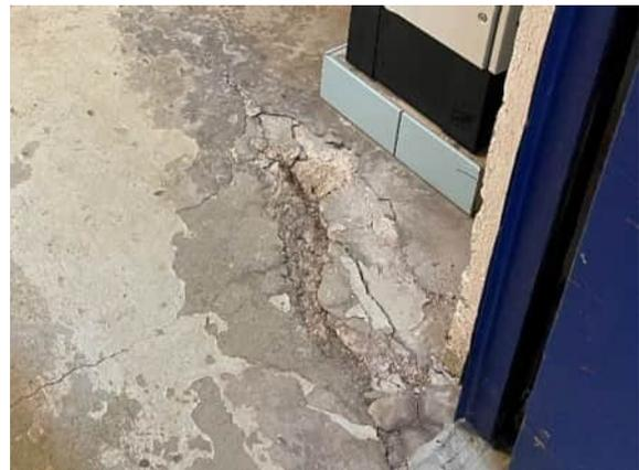
Betonmängel und Risse an der Bodenplatte
