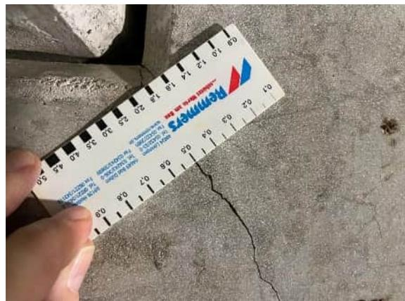
Detail: Konsole mit Riss (bis ca. 1,0mm)
