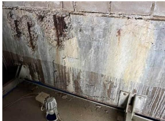
Balken unter Trennwand mit massiven Schäden (Bereich Zugang Duschen – Halle)
