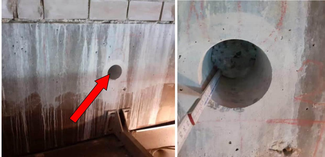
**Bild 29: Ansicht der Entnahmestelle des Bohrkerns 3 Stütze im Kellergeschoss**
