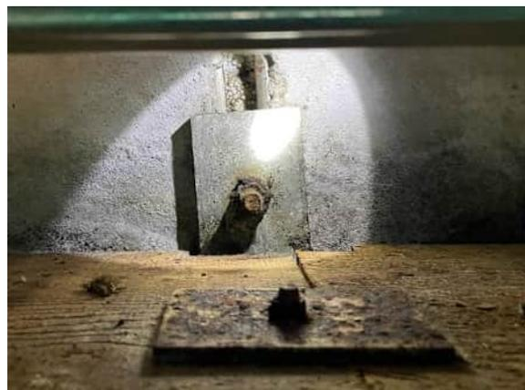
Korrosion im Bereich Fassadenverankerung
