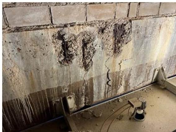
Gravierende Betonschäden am Stb.-Balken
