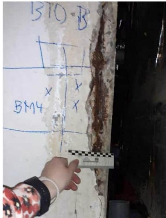
Hauptstütze mit abgeplatzter Betondeckung
