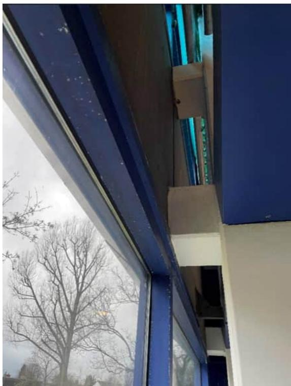
Stb.-Fassadenplatten an Stützen geankert
