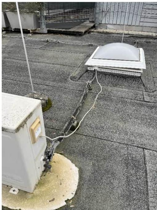
Foto vom 06.02.2024 – Fragwürdige Durchführungen durch die Dachabdichtung
