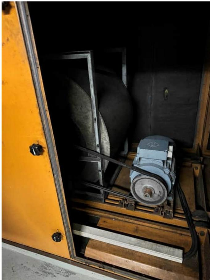
Foto vom 06.02.2024 – KG Technik – RLT-Anlagen mit Riemenantrieb
