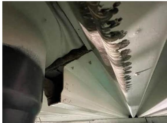
Korrosion im Bereich der Dachentwässerung
