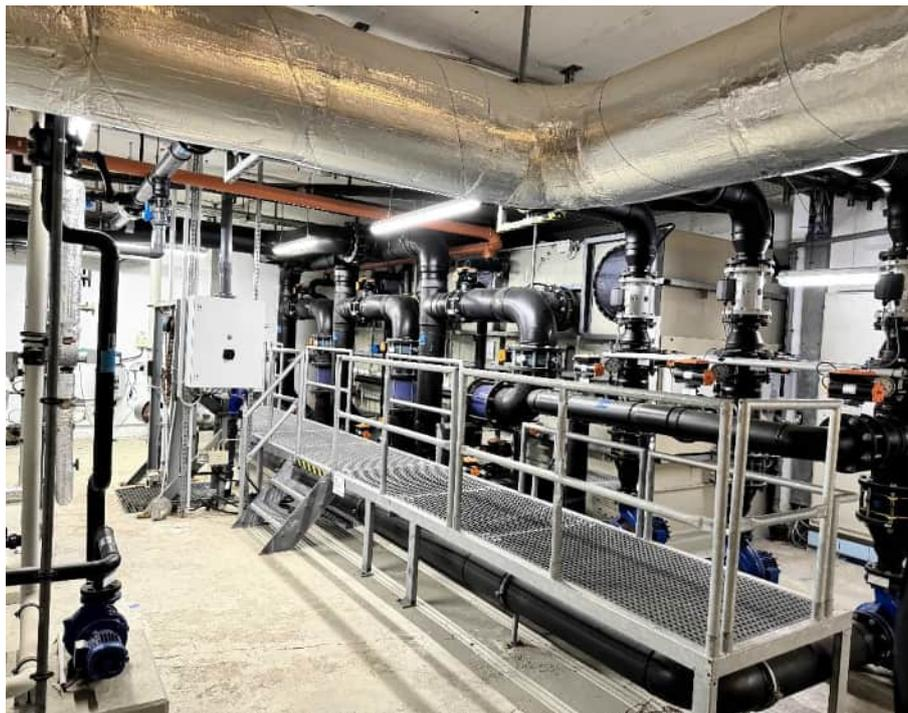
Foto vom 06.02.2024 – KG Technik – Unterdruckfilter mit Filtratpumpen
