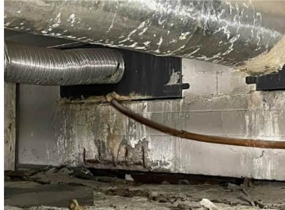
Zuluft-Aussparung mit massiven Schäden
