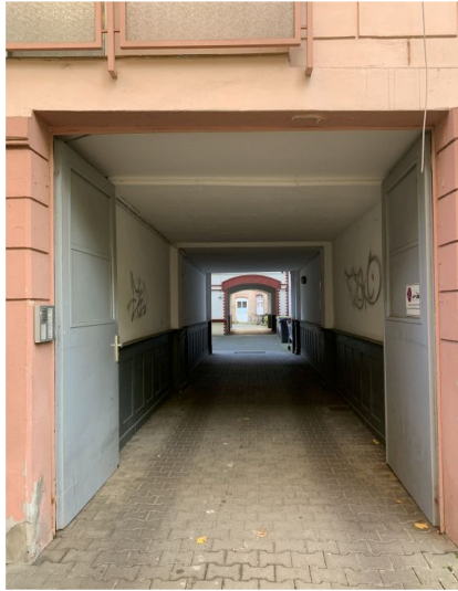
ebenerdiger Durchgang in zwei Hinterhöfe im Westend
