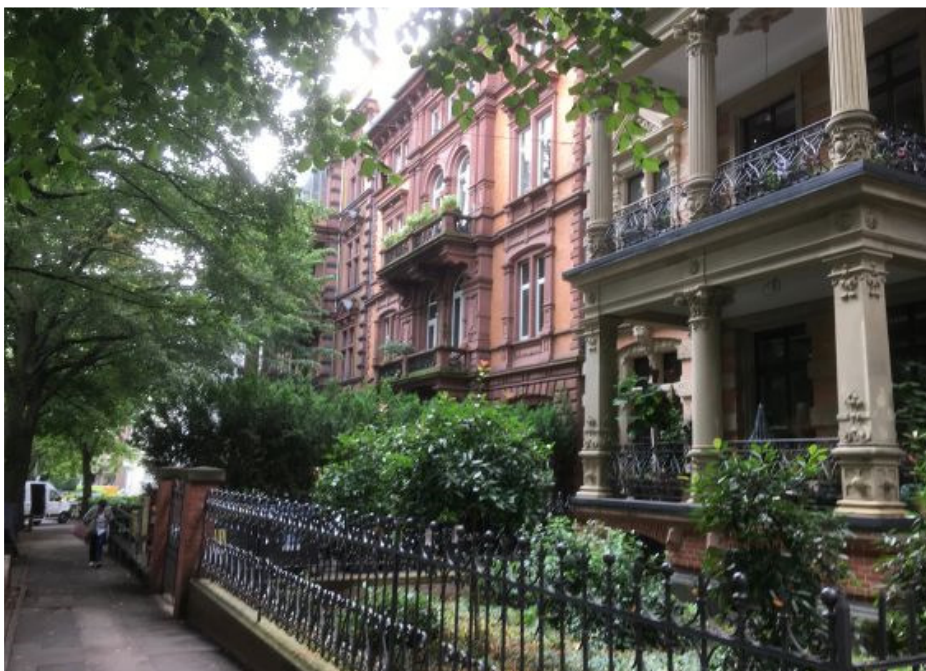
Vorgartensituation in der Rüdeshheimer Straße
