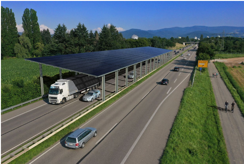
Abbildung 45: Visualisierung einer bifazialen PV-Anlage über einer Autobahn (Fraunhofer ISE, 2021)
