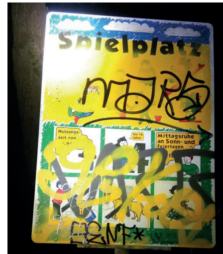
Verschmutzung des Eingangsschildes
