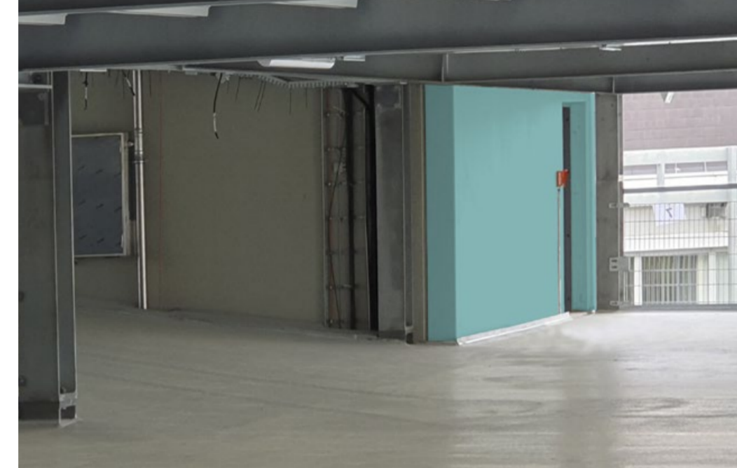
Großes Treppenhaus, Zugang zum Treppenhaus, Wandfarbe klappt an der Ecke um bis Fuge
