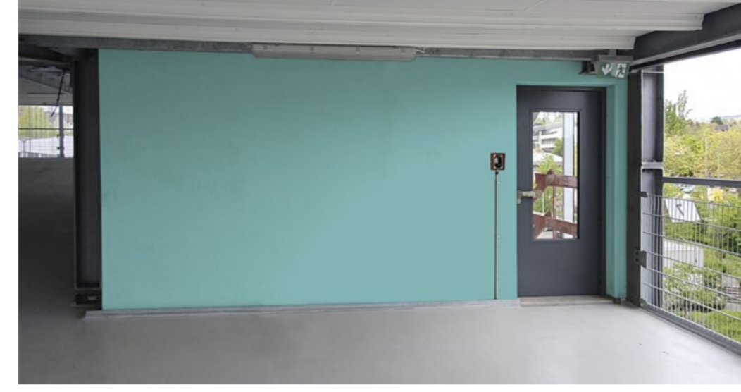
Großes Treppenhaus, Zugang zum Treppenhaus, Farbe über gesamte Fläche bis Stahlstütze
