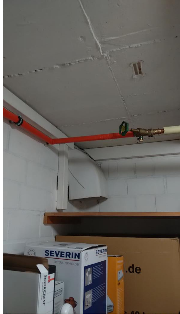
Wasser- und Lüftungsinstallation Keller UG
