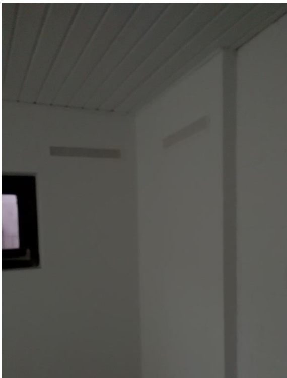
Hinterlüftete Vorwand vor Außenwand
