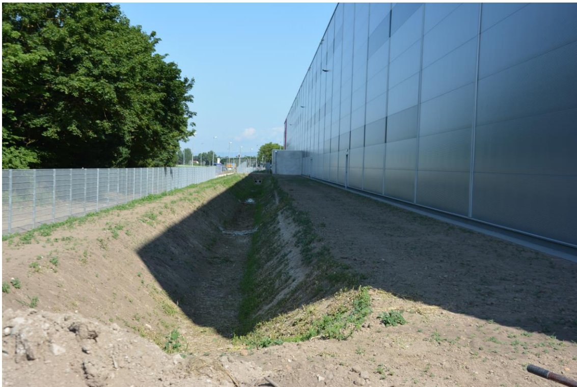
Abbildung 7: Versickerungsmulde auf einem Grundstück (planD)
