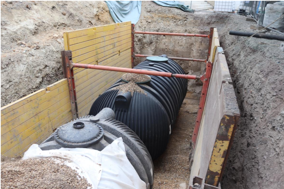
Abbildung 5: Einbau einer Zisterne (planD)
