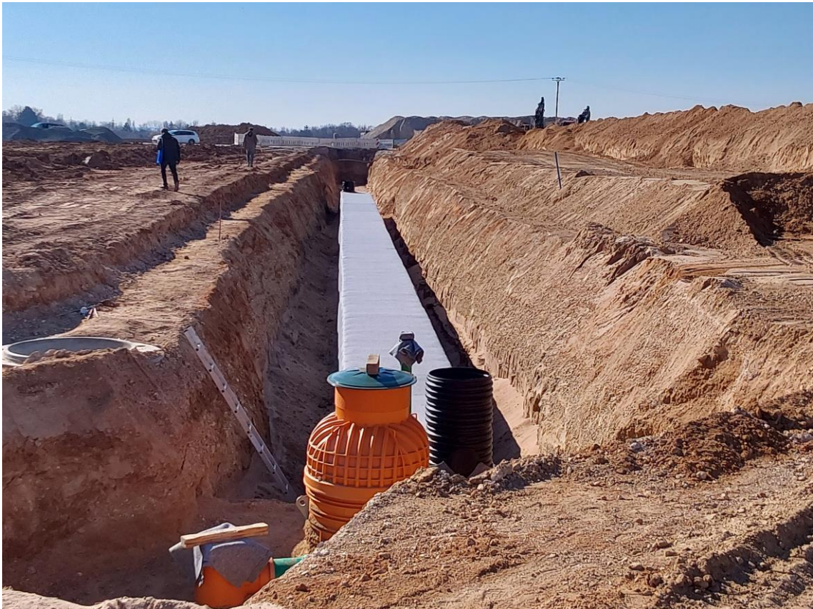
Abbildung 3: Einbau eines Regenrückhaltebeckens (planD)
