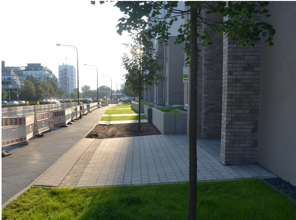
Abbildung 6: Rinne mit Versickerung in den Bodenanschluss (planD)
