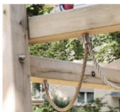
Materialität pulverbeschichteter Stahl (Rundrohr) in Kombination mit Holz (unbehandelt, geradlinig), Edelstahlseilnetzen und farblich gestaltete Spieltaue / Kletternetze.
