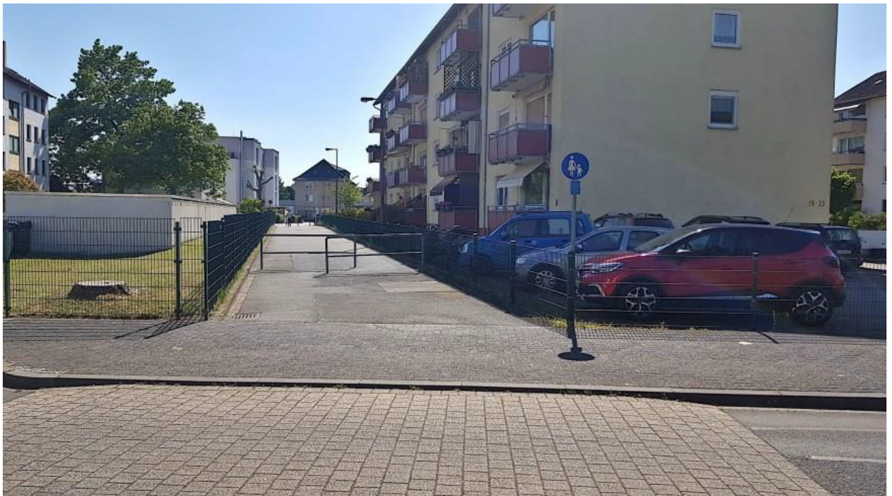
Abbildung 2: Blick von der Marie-Juchacz-Straße auf den Weg. Dieser ist derzeit als Gehweg ausgeschildert und mit zwei Umlaufgittern versehen.
