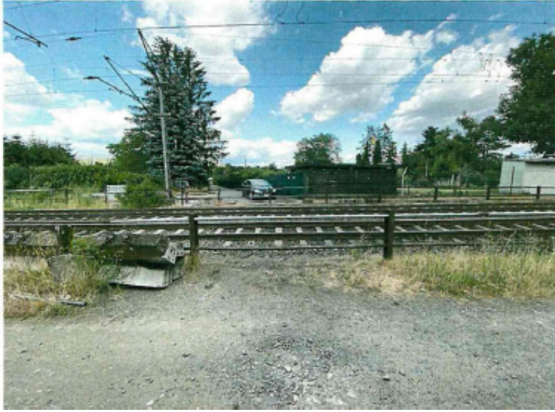
Von Fußgänger*innen und Radfahrer*innen regelmäßig genutzter illegaler Gleisüber-gang
