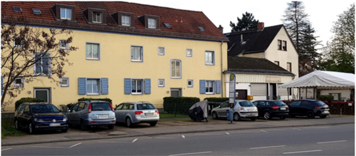
Abbildung 1: Bushaltestelle Hallgarter Straße (Fahrrichtung Hochheimer) in MainzKostheim
