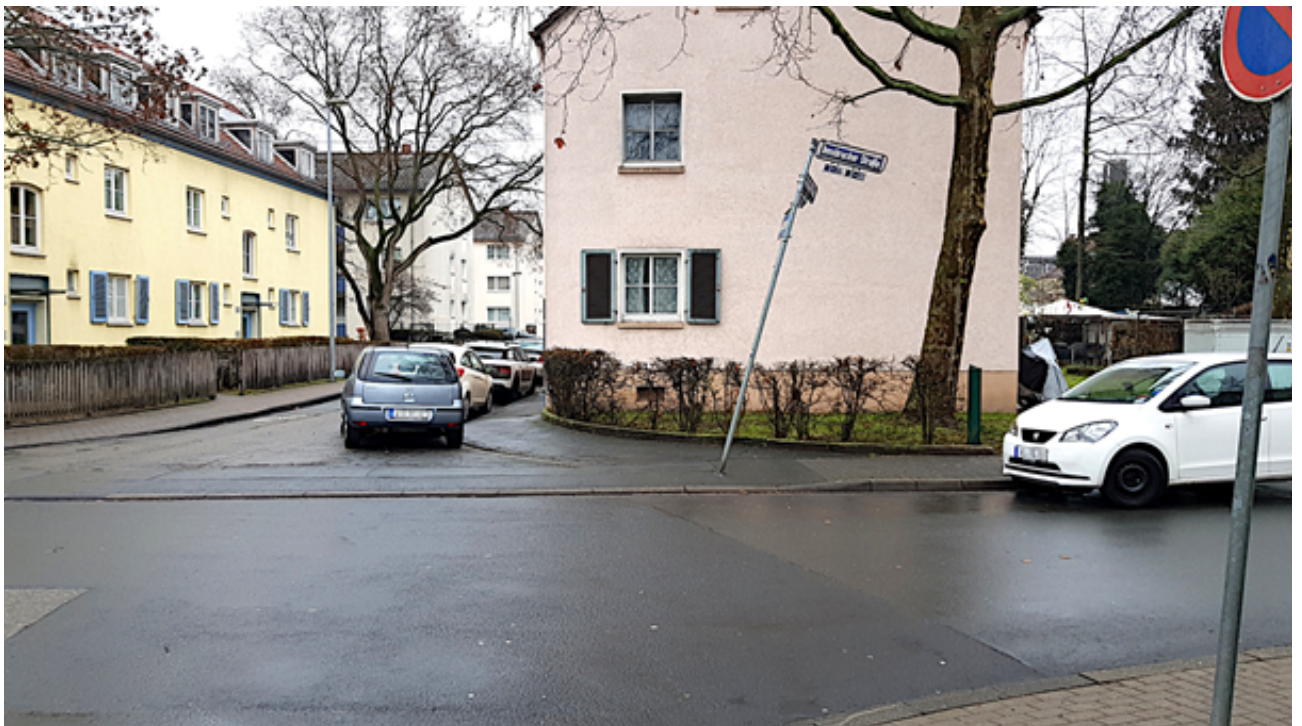
Abbildung 2: Das Straßenschild an der Ecke Innsbrucker / Salzburger Str. wird regelmäßig beschädigt. Mutmaßlich durch Autos, die in dem Bereich regelwidrig parken
