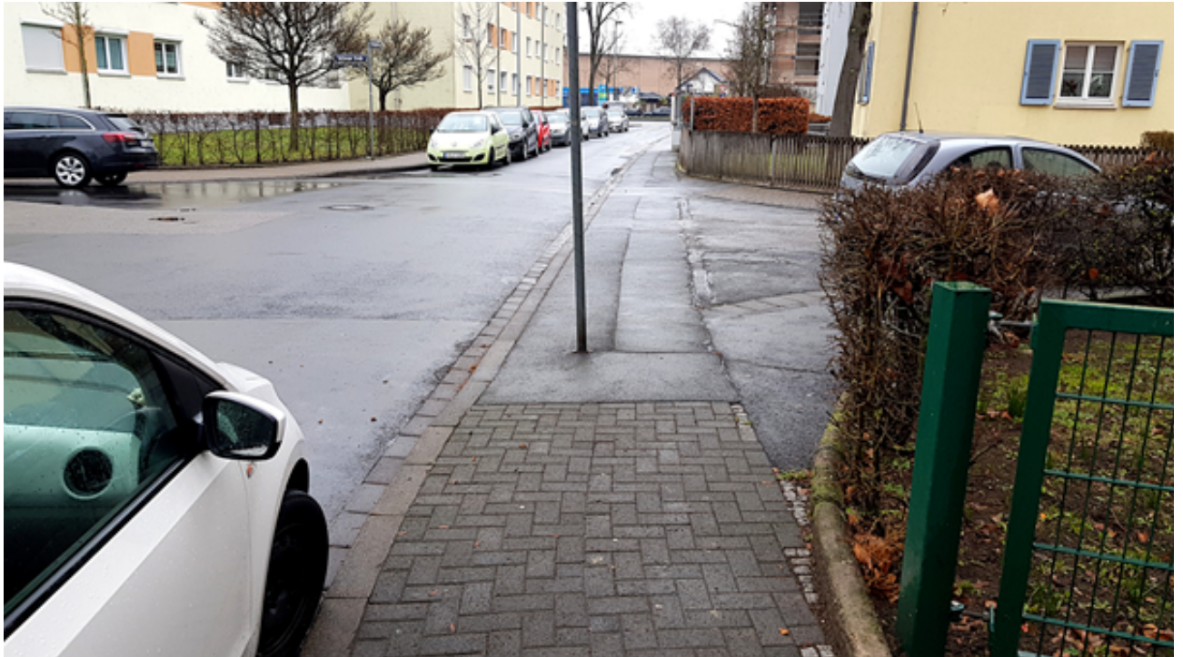
Abbildung 1: Die Abgrenzung des Gehwegs (nach rechts abbiegend) ist im Einmündungsbereich unklar. Die gepflasterte Gehwegkante endet unerwartet
