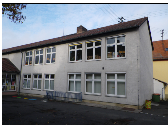
1950er Jahre Schulgebäude, Hofansicht
