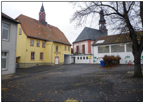
Pausenhof, Blick nach Nordosten
