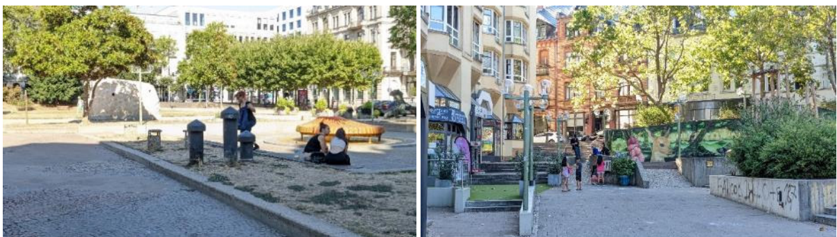
Abbildung 4: Abluftkamine für Brunnenkammer (li.), Höhensituation und Spielplatz (re.). Aufnahmen: Stadtplanungsamt (2022).
