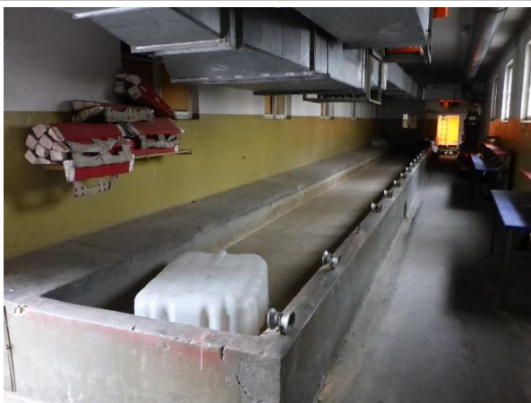
Abbildung 18 Schlauchwanne im ehemaligen Feuerwehrgebäude
