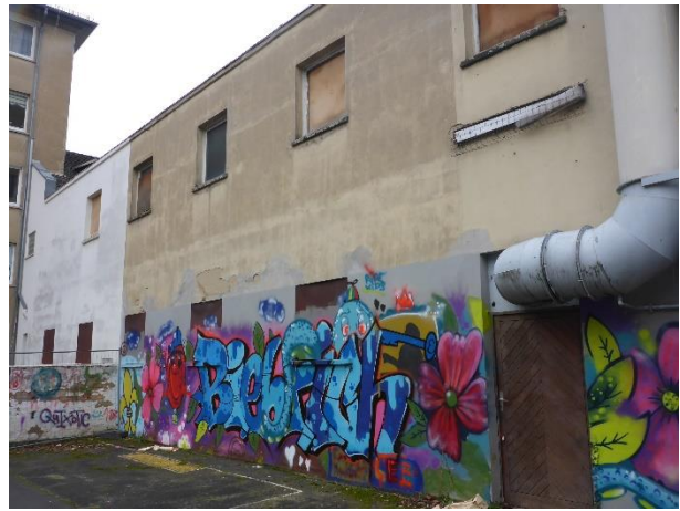
Abbildung 15 Fassade des Anbaus der Feuerwehr
