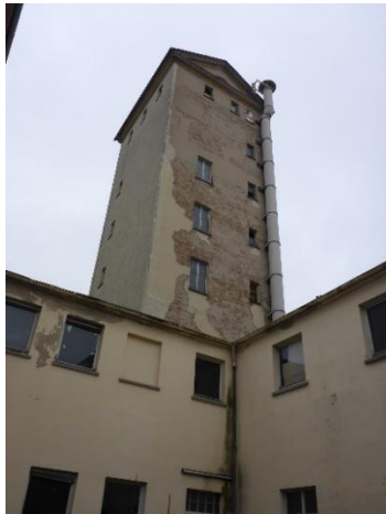
Abbildung 14 Fassade des Turms
