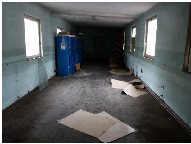
Abbildung 17 Innenraum des Anbaus der Feuerwehr
