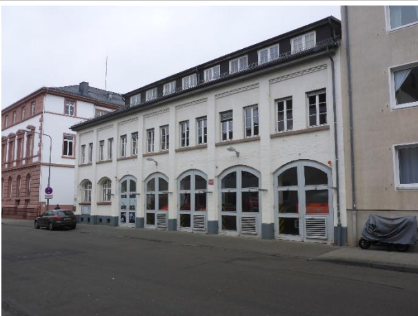
Abbildung 12 Blick von der Wilhelm-Tropp-Straße
