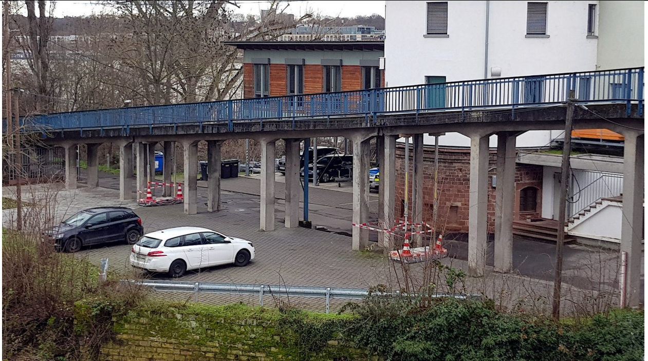
Abbildung 1: Blick auf das Gelände der Wasserschutzpolizei auf der Maarau. Die zusätzlichen Stützen sind mit Flatterband und Pylonen abgesperrt.
