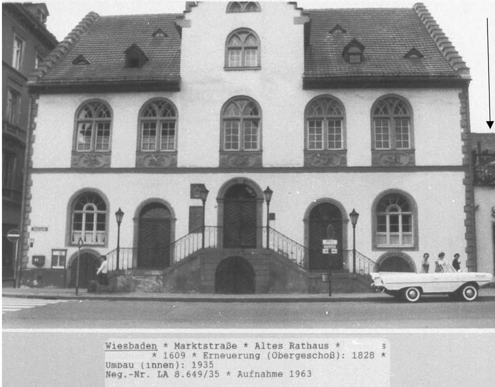
In der Aufnahme von 1963 sind sämtliche Sandsteinbauteile dunkel (vermutlich rot) zur Fassadenfläche abgesetzt.
