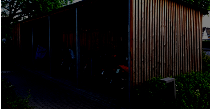
Abbildung 1: Überdachte Fahrradgarage zwischen Passauer und Kostheimer Landstraße; ähnlich etwa auch in der Salzburger Straße zu finden. Hiervon könnte es noch mehr in Kostheim geben.
