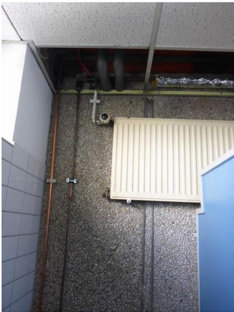
Abbildung 30 Heizkörper, offene Decke im WC-Raum
