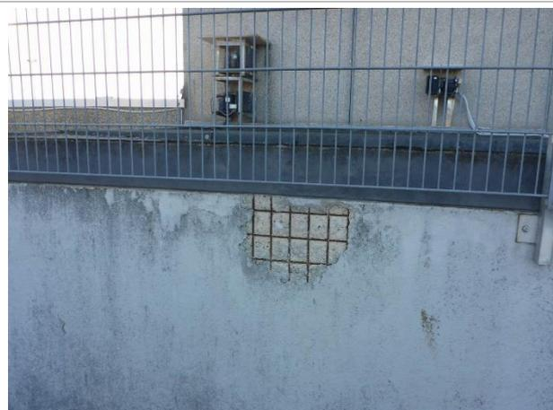
Abbildung 13 Mangel der Fassade, freigelegter Stahl
