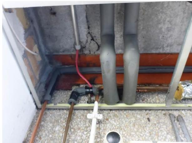
Abbildung 43 Rohr- und Leitungsführung; Risse in der Decke
