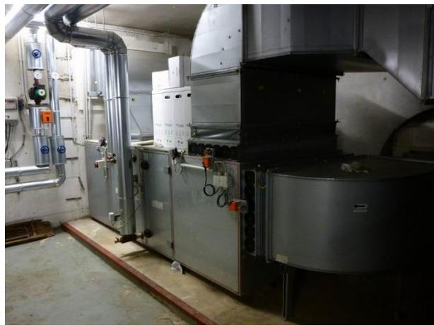
Abbildung 51 Lüftungsanlage Keller
