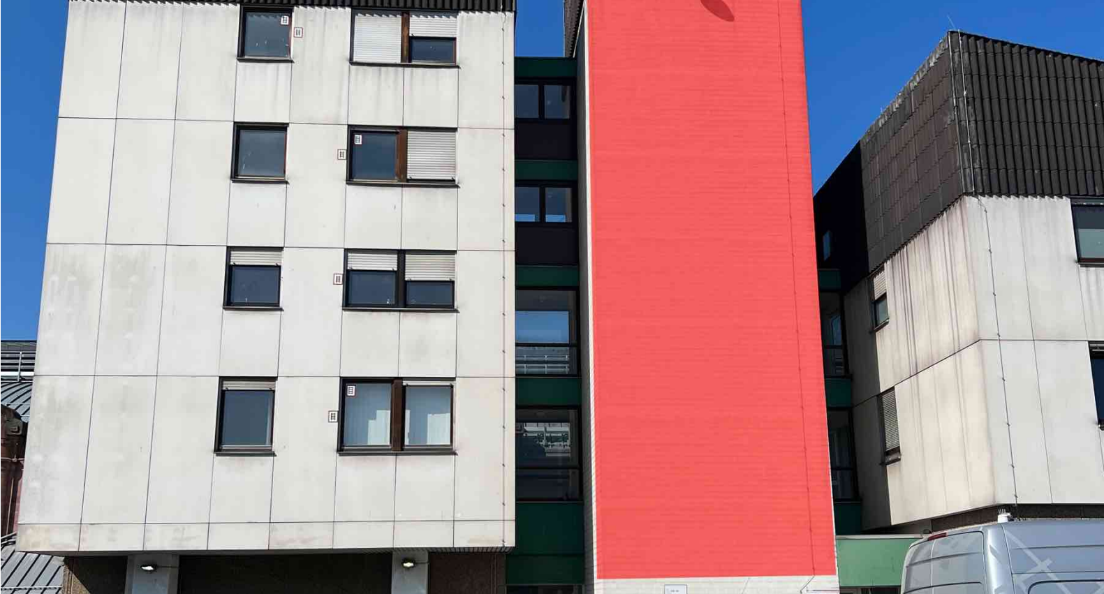
Fassade am östlichen Anbau des Hbf
