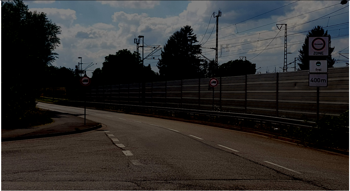
Abbildung 3: Derzeitige Situation an der Kreuzung Kommerzienrat-Disch-Brücke/Bruchstück/Hauptstraße. Die Einfahrt für LKW ist beidseitig mit Verkehrszeichen 253 verboten. Das Verkehrszeichen 270.1 („Umweltzone“ mit Zusatzzeichen) könnte versetzt werden, damit das LKW-Einfahrtsverbot besser gesehen wird.
