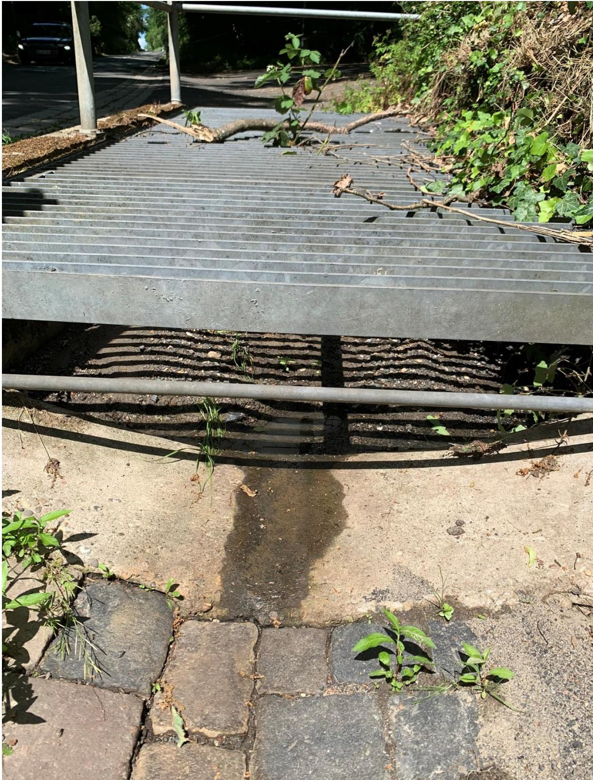
Bild 2: Abfluss in die Kanalisation am unteren Ende der Entwässerungsrinne
