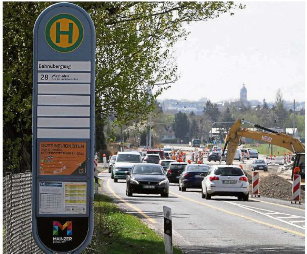
An der Haltestelle „Bahnübergang“ hält wegen der Bauarbeiten auf der Boelckestraße zurzeit kein Bus.
