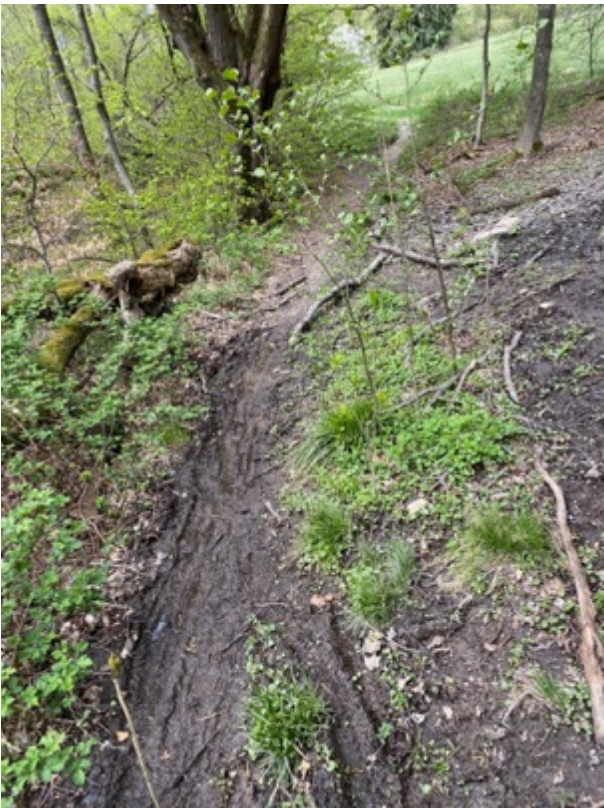
Abb.4: Stark erodierter Boden entlang des Wanderweg-Abschnittes.
