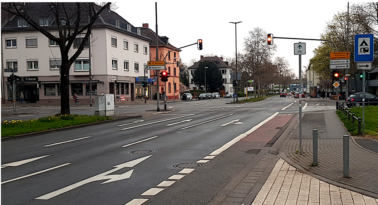
Abbildung 4: Beispiel für die Radverkehrsführung an einer Kreuzung ohne Aufstellfläche bzw. ohne „Aufgeweiteten Radaufstellstreifen“ (ARAS). Am rechten Fahrbahnrand ist ein Schutzstreifen für Radfahrer vorhanden. Hier vom Philippstr. mit Blickrichtung in die Hochheimer Straße .
