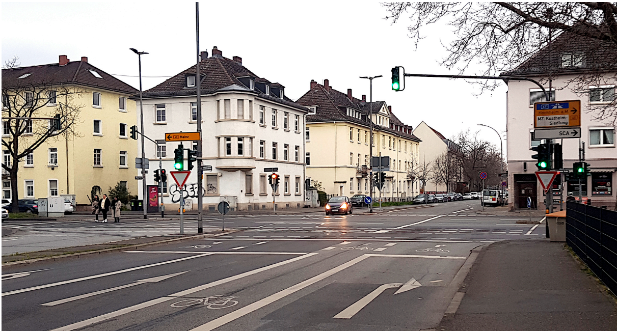
Abbildung 5: Beispiel für die Radverkehrsführung an einer Kreuzung mit Aufstellfläche bzw. mit „Aufgeweiteten Radaufstellstreifen“ (ARAS). Hier von der Kostheimer Landstraße mit Blickrichtung in die Admiral-Scheer-Straße , Mainz-Kastel. Für alle Verkehrsteilnehmer ist klar, dass Radfahrerinnen und Radfahrer links abbiegen können und dürfen.
