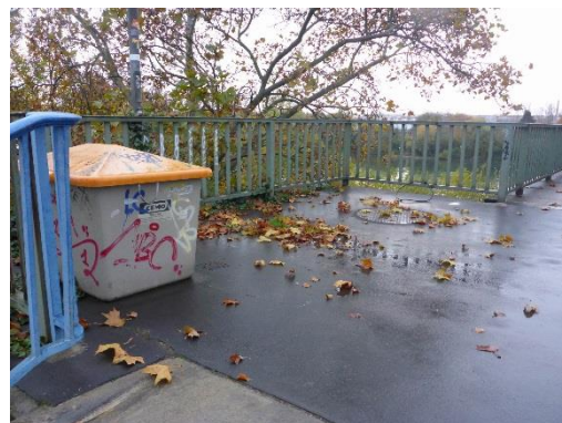
Abbildung 11 Hauptpodest am Übergang zur Brücke
