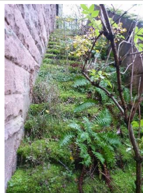
Abbildung 19 stillgelegte Treppe nördlich der Kaiserbrücke
