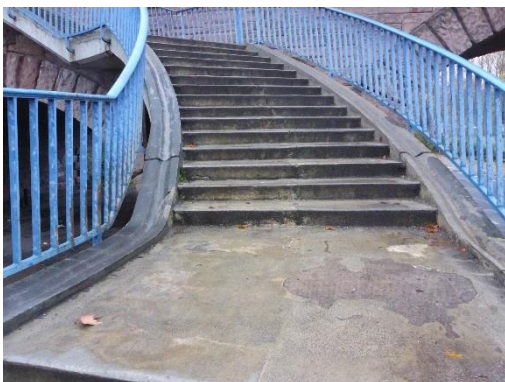
Abbildung 10 Spurrinnen für Fahrräder links u. rechts
