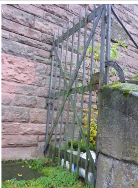
Abbildung 18 Absperrung Treppe, Nordseite
