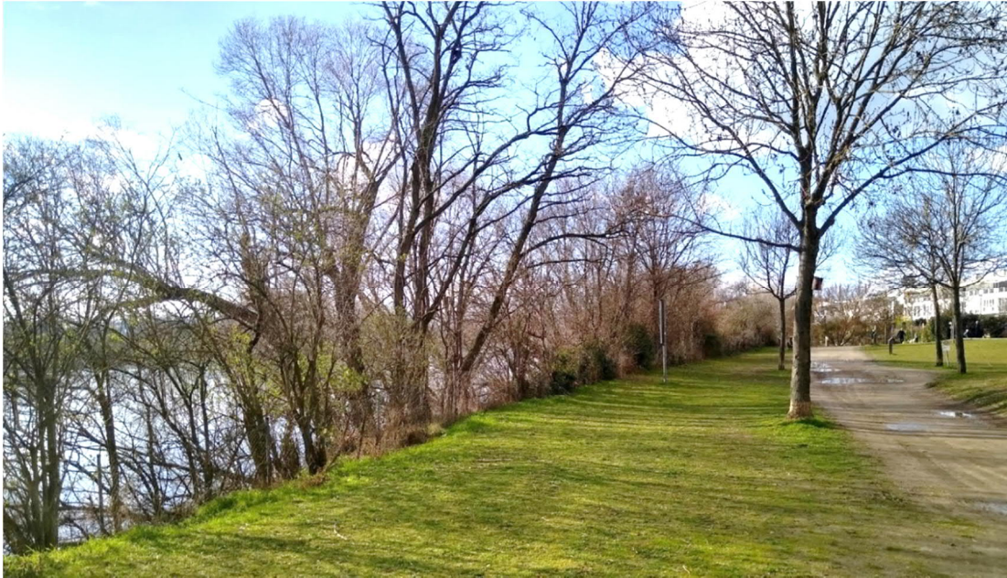
Abbildung 51: Rheinuferböschung entlang der Parkanlage (Quelle Abbildungen 45-48: Götte Landschaftsarchitekten, 2021)
