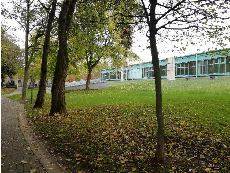
Abbildung 11: Begrünte Dachfläche der bestehenden Sporthalle; Quelle: PgD
