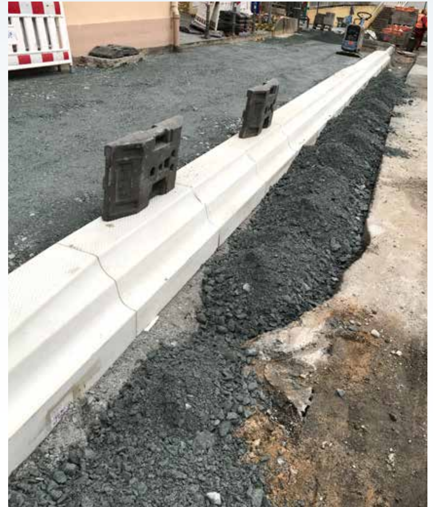
Abbildung 20: Einbau eines Hochbordes während der Baumaßnahme
