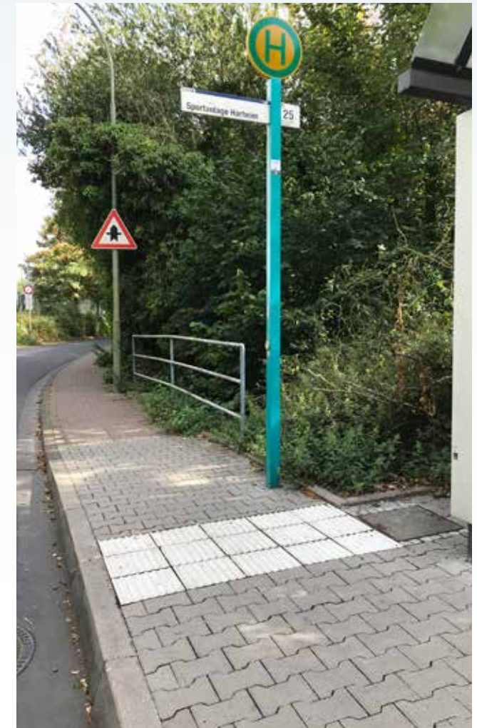
Abbildung 23: Langjährig in Betrieb befindliche, schmale Haltestelle mit durchgängigem Auffindestreifen (Kombination von Bodenindikatorelementen) in Harheim
