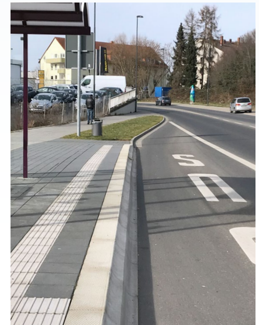
Abbildung 18: Barrierefrei gestaltete Busbucht in Bad Vilbel/Kennedy-Schule
