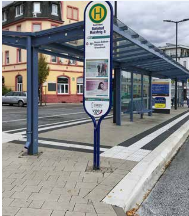
Abbildungen 15: Busbahnhof Bad Vilbel, Haltestellenbereich in Insellage mit mehreren Einstiegsbereichen
