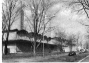
Die beiden von Ernst Neufert errichteten Wärmetauscher-türme bilden zusammen mit den davor liegenden riesigen Drehöfen das Herzstück der Wiesbadener Zementproduktion. Von 1967 bis 1970 im Vierendeel-Raumfachwerk mit freigestellten Ecken erbaut, wurden die komplizierten technischen Einrichtungen in dieses großräumige Gitternetz mühelos eingefügt. Von den beiden
