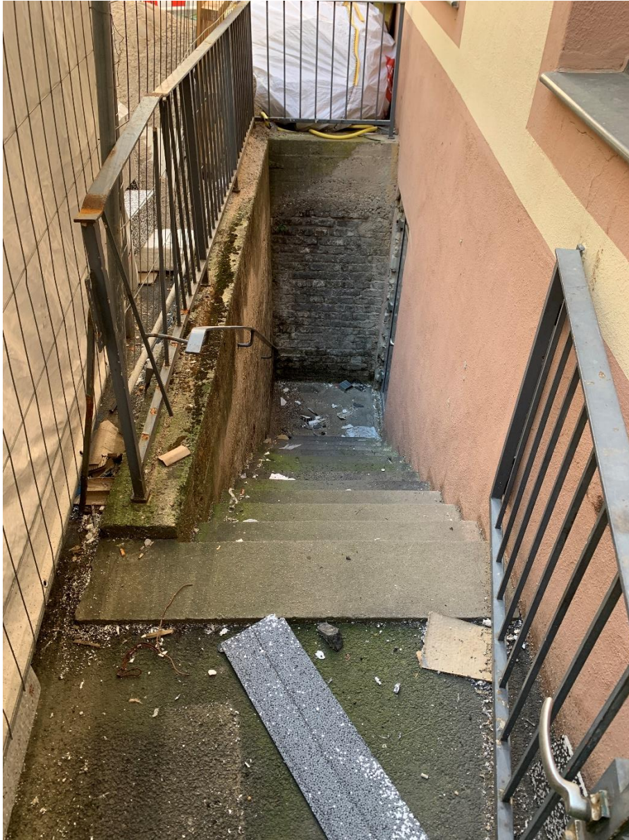
Blick Richtung Notausgang
