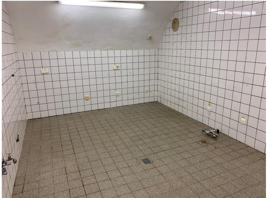
Ansicht ehemalige Küche
