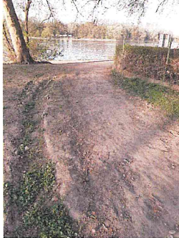
Wegeschaden nach Hochwasser
