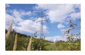
Der Landschaftliche Eingriff für die Herstellung einer 110-kV-Kabeltrasse ist deutlich größer als bei einer Freileitung.
