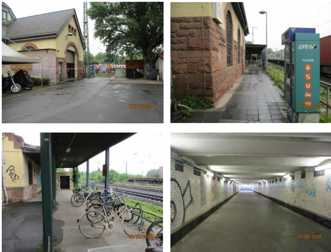
Abbildung 12 - Zugang zum Bahnsteig von der Straße sowie Personentunnel
