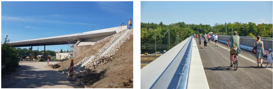
Abbildung 16 – Beispiel Wasserwerkbrücke Karlsruhe 2019 [ https://reif-bau.de/ ] 1
