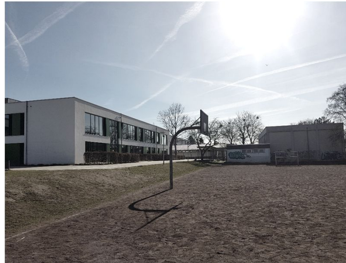
Gesamtansicht von Nordosten gesehen
