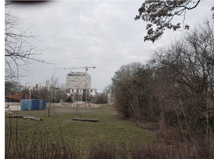
Erschließung Baufeld an der Grundstücksgrenze
