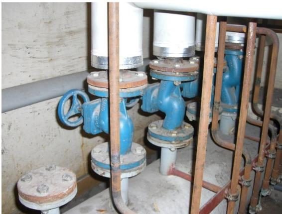
Abbildung 7: Asbesthaltige Flachdichtungen im UG
