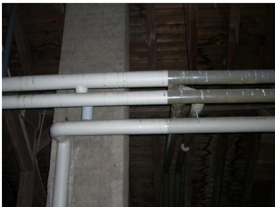
Abbildung 8: Lüftungskanal aus Asbestzement im DG
