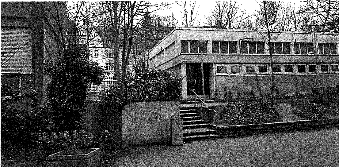
Anschluss Halle zu Nachbargebäude
