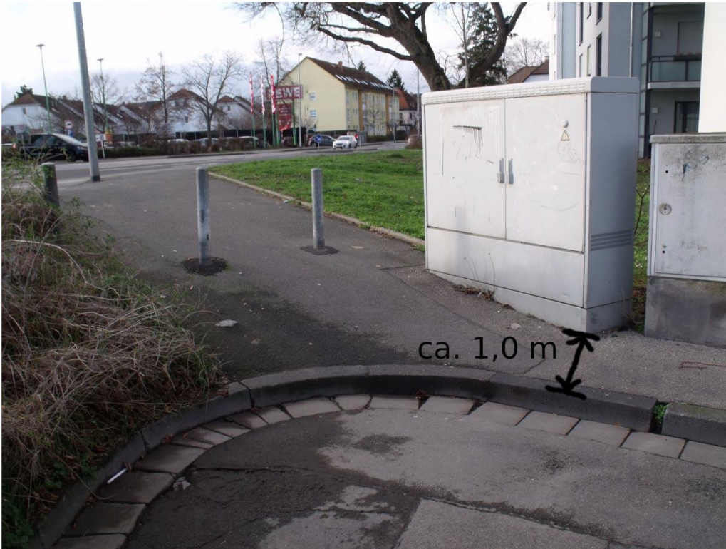
Abbildung 4: Engstelle auf dem Gehweg aufgrund eines Verteilerkastens
