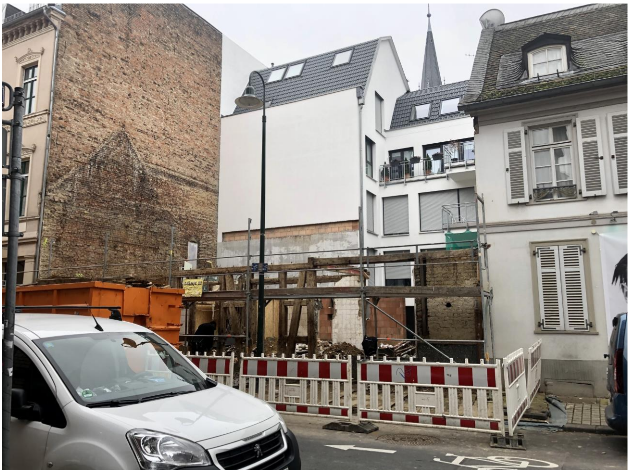
Zustand während der Demontage des historischen Fachwerks (Aufnahme: Denkmalschutzbehörde Wiesbaden)
