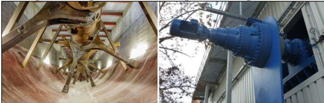
Abbildung 8: Darstellung Rührwerk und außen liegendes Planetengetriebe
