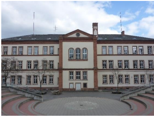
Abbildung 5 –Hauptgebäude Ansicht vom Hof
