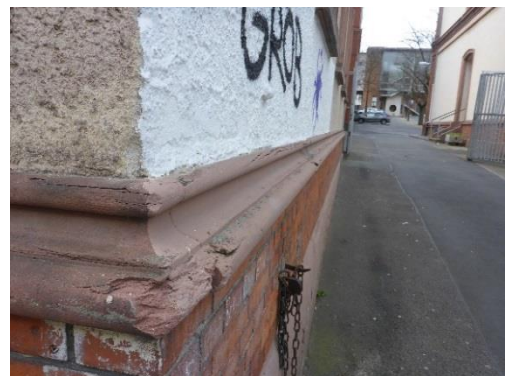
Abbildung 10 — Fassadenschäden Hausmeistergebäude
