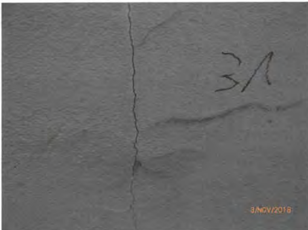
Bild 39: Achse A, Block 31: senkrechte / waagerechte Rissbildung
