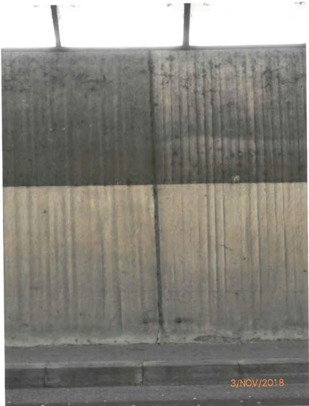
Bild 46: Achse B, Block 56/57: Altanstrich / Beschichtung; Sichtbeton
