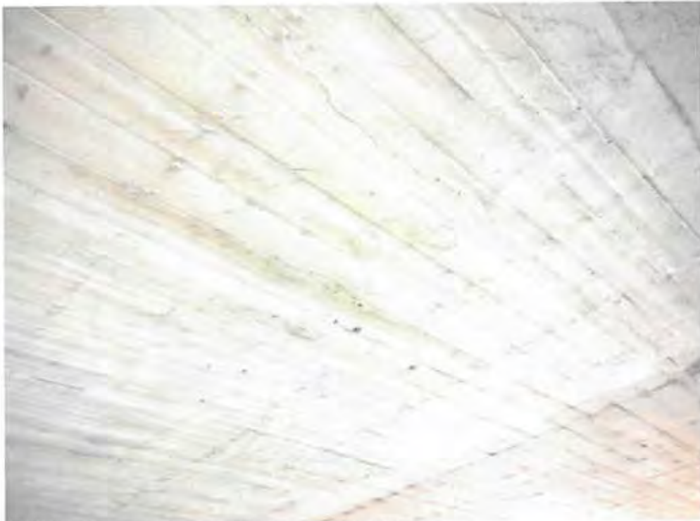
Bild 64: Deckenunterseite: Sichtbeton, Rissbildung
