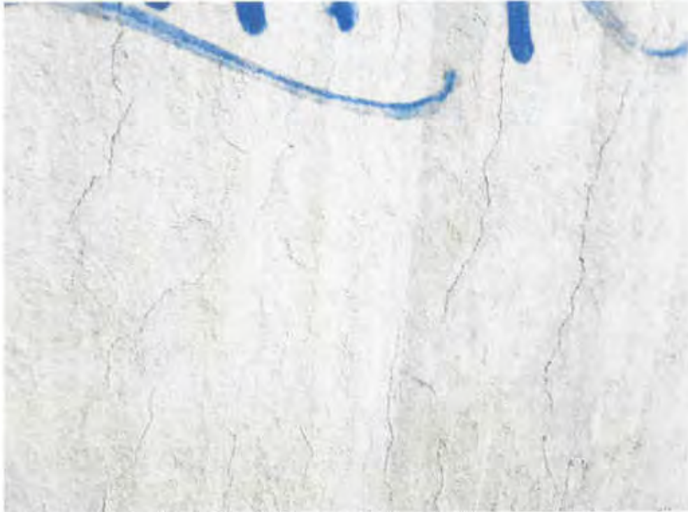
Bild 36: Achse B, Block 52: Rissbildung in Spachtelschicht
