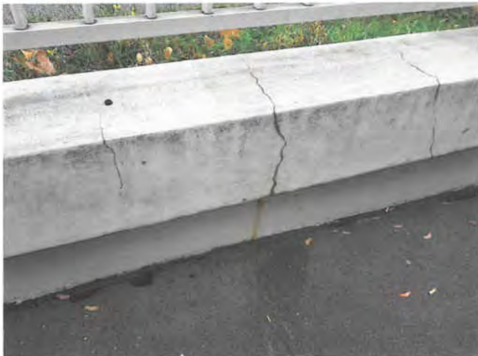
Bild 79: Achse C, Block 3: Kappe mit Rissbildung
