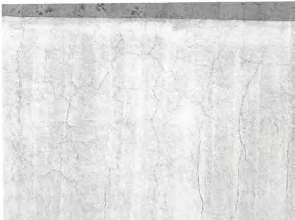
Bild 41: Achse B, Block 51: Netzrisbildung
