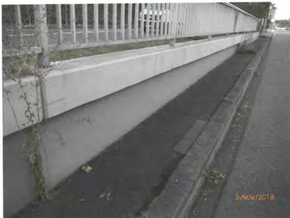
Bild 70: Achse A, Block 40: Kappenausbildung, Rissbildung
