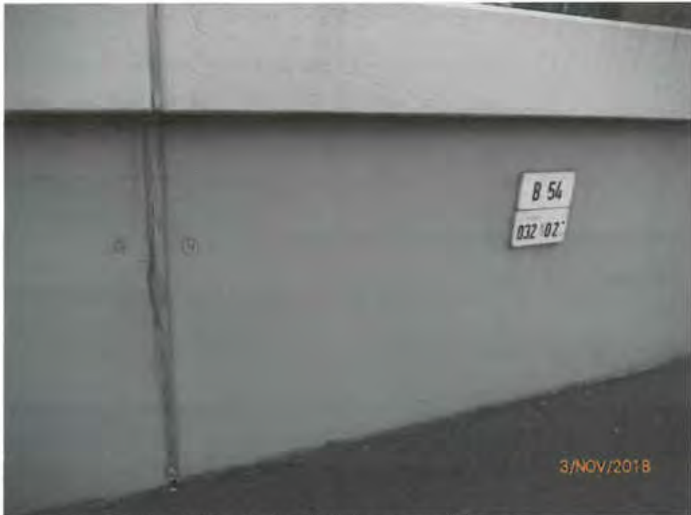
Bild1: Achse A, Block 37/36: Spachtelschicht, Beschichtung
