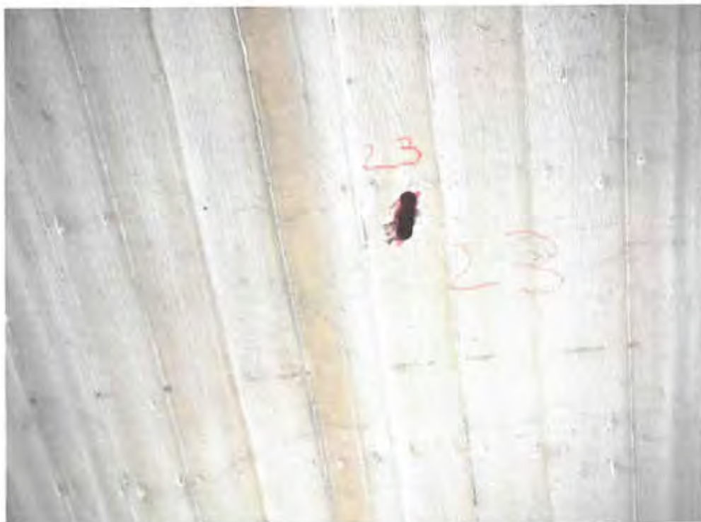
Bild 69: Deckenunterseite: Sichtbeton; Messstelle Karbonatisierungstiefe
