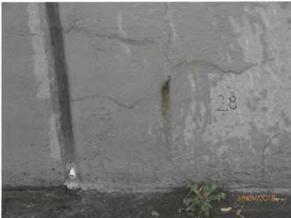
Bild 38: Achse A, Block 28: senkrechte / waagerechte Rissbildung
