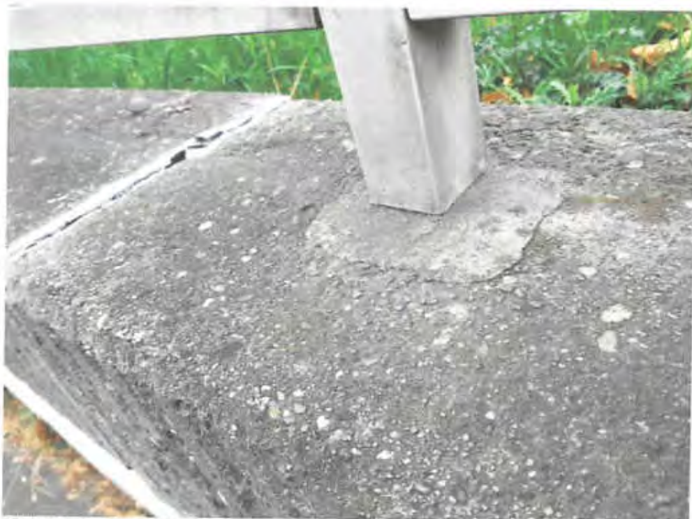
Bild 110: Geländerpfostenverankerung
