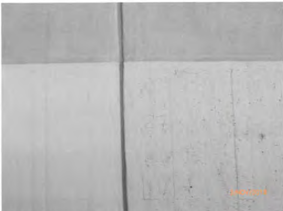
Bild 9: Achse D, Block 28/27: Spachtelschicht, Beschichtung
