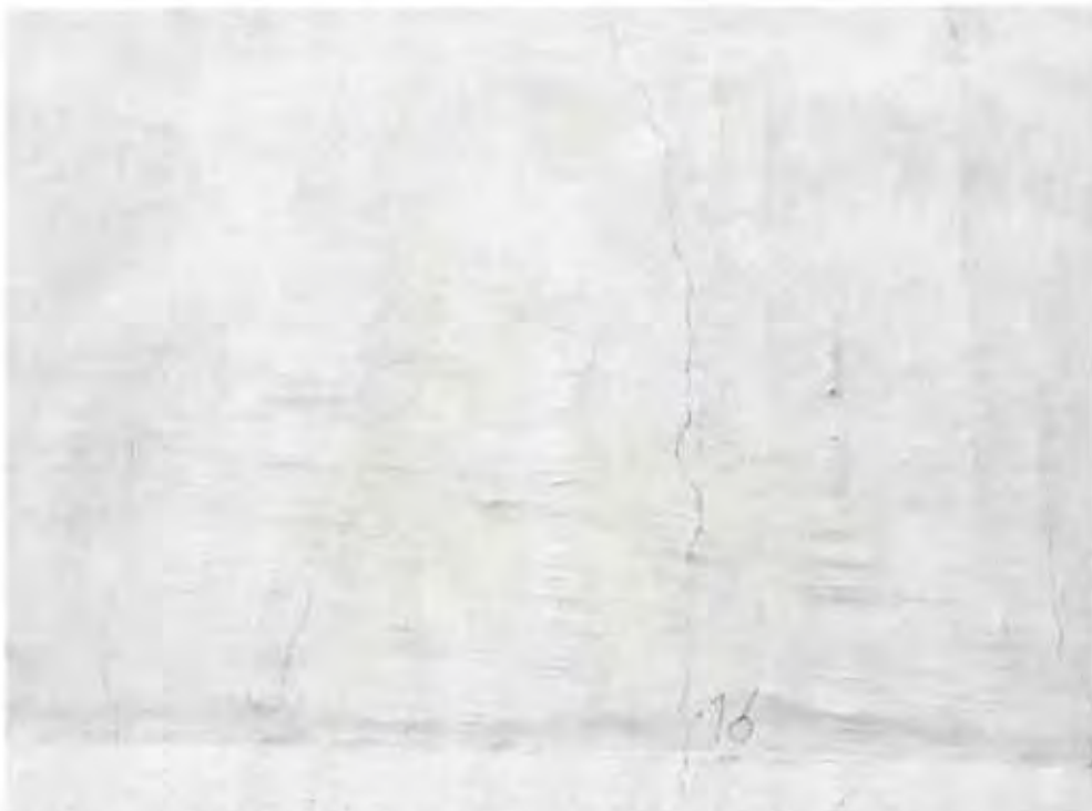
Bild 37: Achse C, Block 16: Senkrechte Rissbildung in Spachtelschicht
