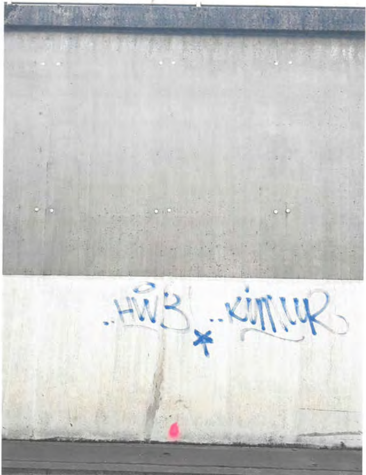
Bild 14: Achse B, Block 52: Altanstrich, Beschichtung / Sichtbeton
