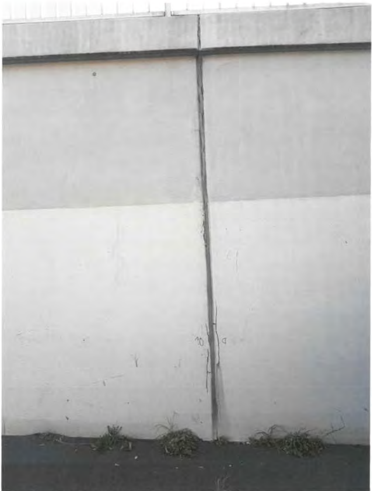
Bild 13: Achse D, Block 10/9: Spachtelung
