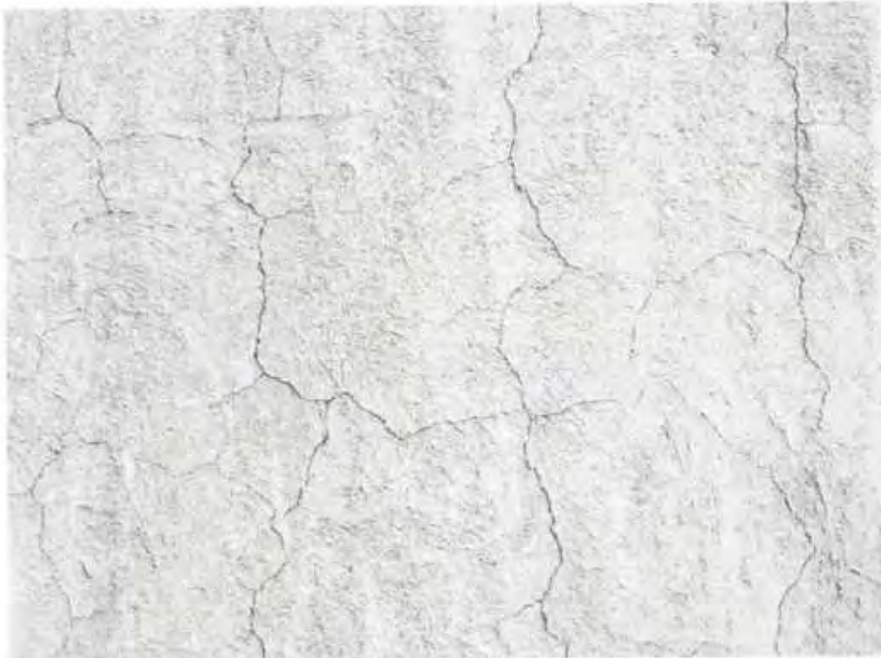
Bild 40: Achse B, Block 50: Netzrisbildung
