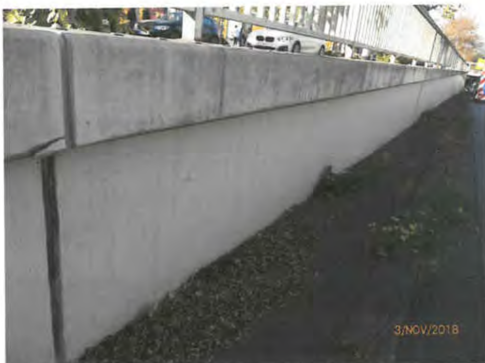
Bild 71: Achse D, Block 38: Kappenausbildung, Rissbildung
