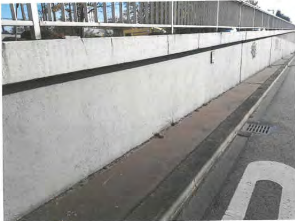
Bild 72: Achse A, Block 44: Kappenausbildung, Rissbildung
