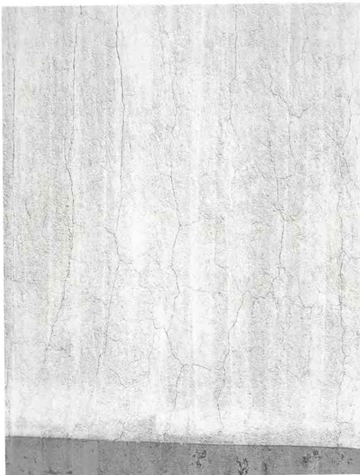
Bild 42: Achse c, Block 7: senkrecht-/ Netzzisse
