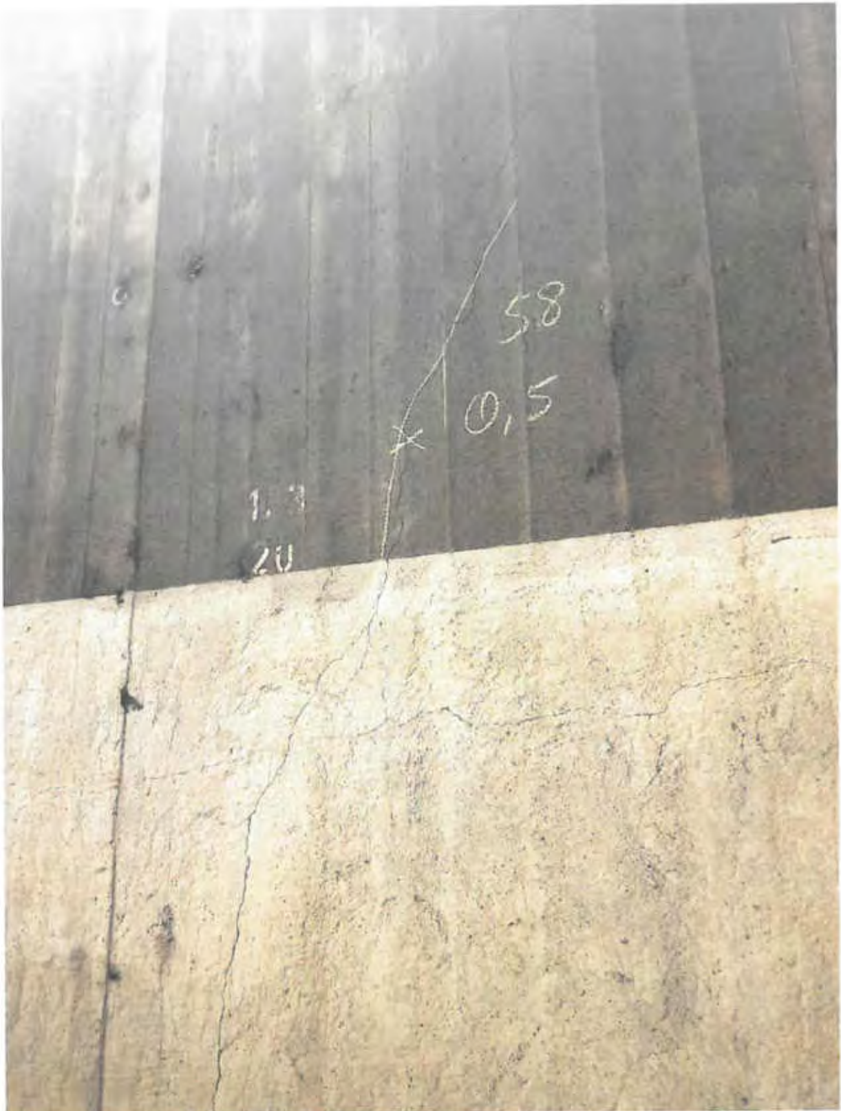
Bild 55: Achse B, Block 58: senkrechter Trennriss
