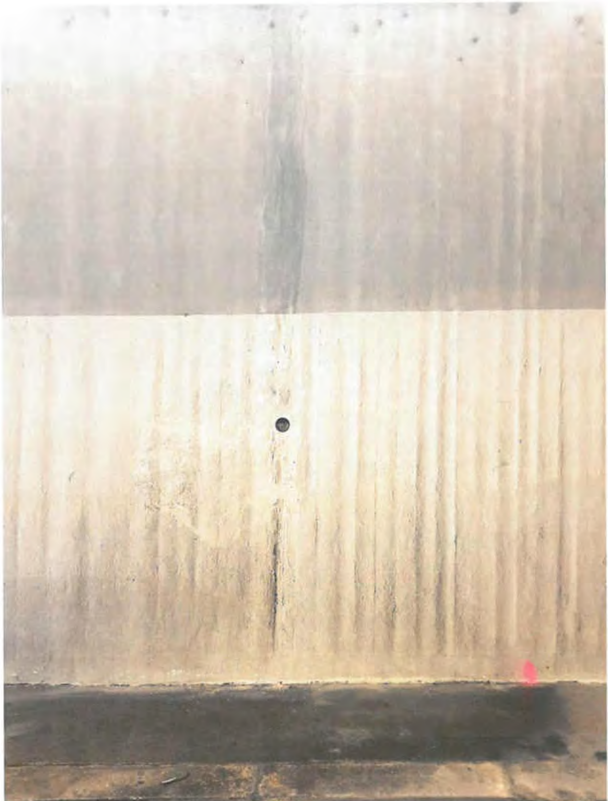
Bild 47: Achse C, Block 18: Spachtelschicht, Beschichtung
