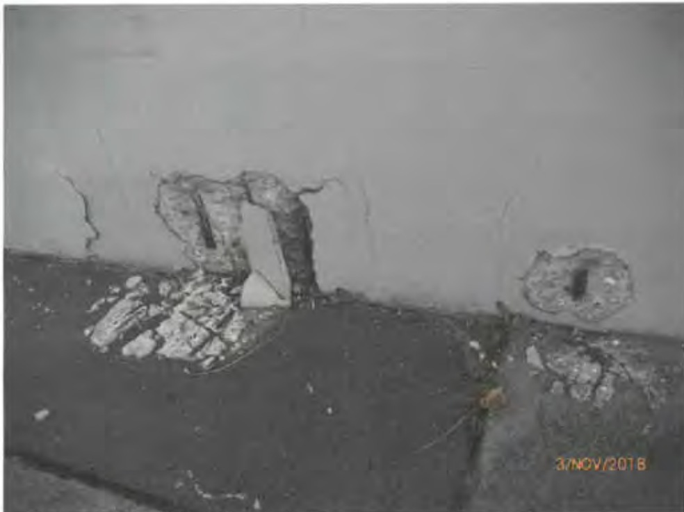
Bild 25: Achse A, Block 34: Betonabplatzungen, Bewehrungskorrosion
