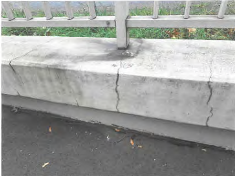
Bild 78: Achse C, Block 3: Kappe mit Rissbildung
