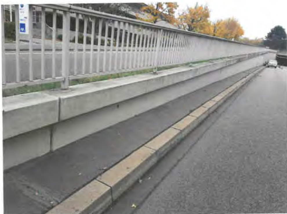
Bild 73: Achse C, Block 3: Kappenausbildung, Rissbildung
