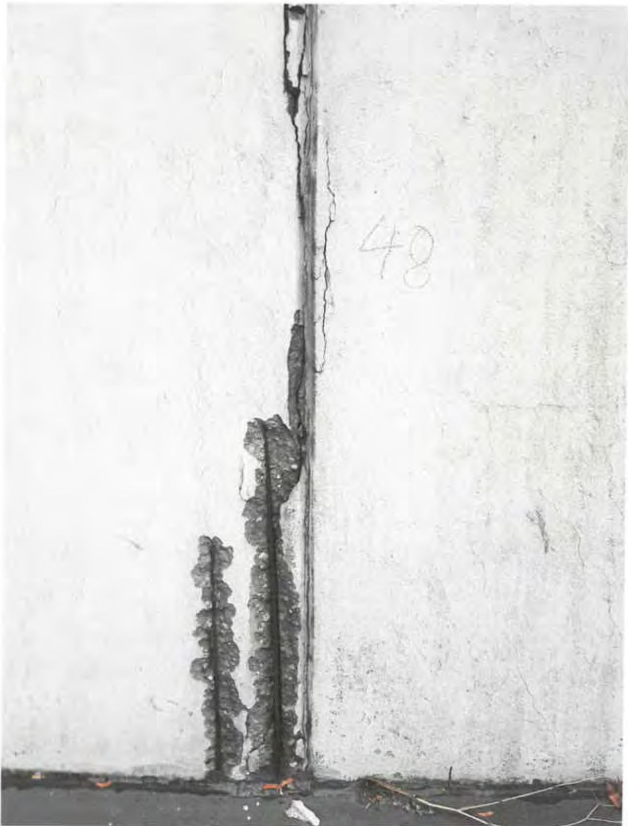
Bild 98: Achse B, Block 48/49: schadhafte Bewegungsfuge
