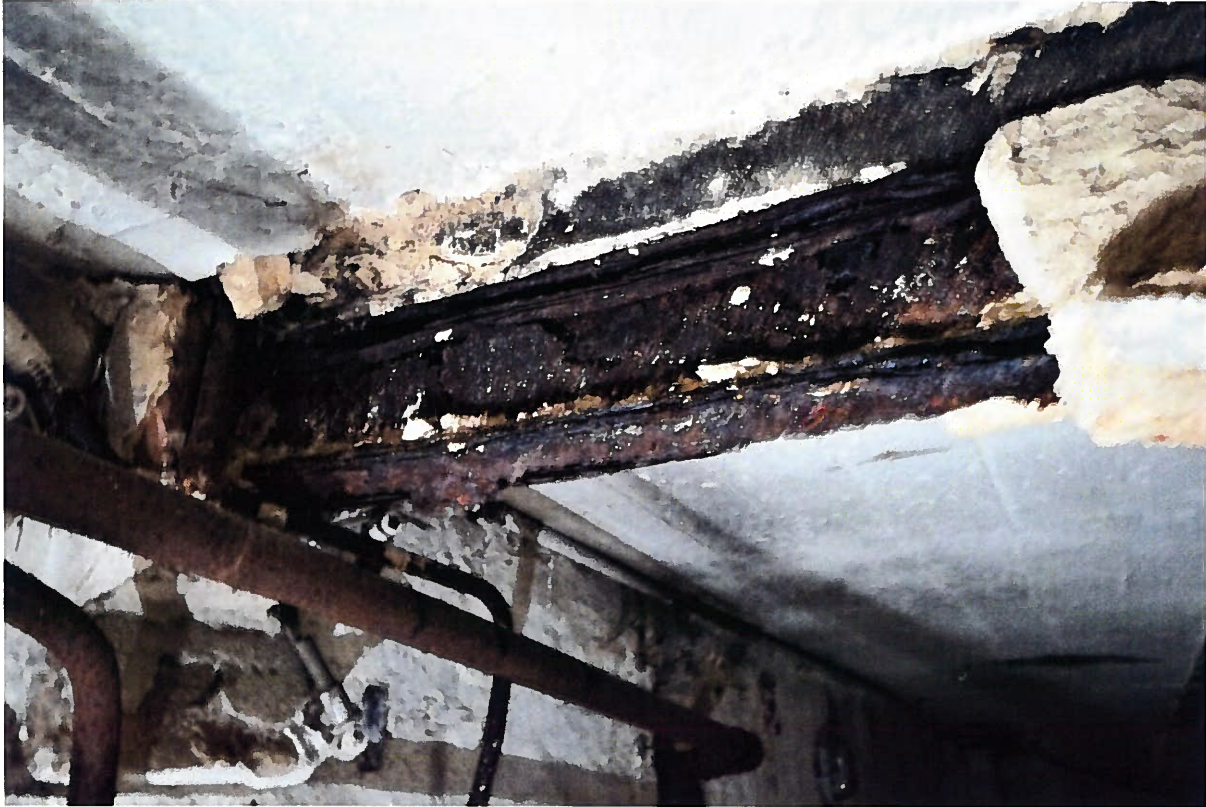
Abb. 55 Raum U1.C80 Decke Beton mit ursprünglich verputzten Unterzug
