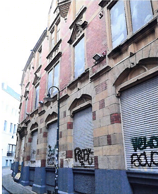
Abb. 34 Fassade Hochstättenstraße, Sept. 2017
