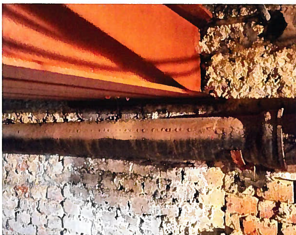
Abb. 15 U 2 E. 81 Norden, Ziegelpfeiler unter Stahlträger, Sept 2017
