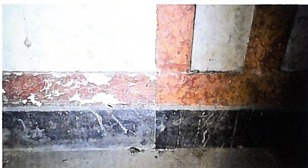
Abb. 37 Raum E0. B.44, links Zusetzung einer ursprünglichen Tür
