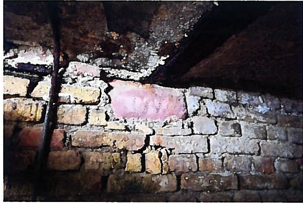
Abb. 14 U 2 D.61 Sandsteinauflager, Osten, Sept. 2017
