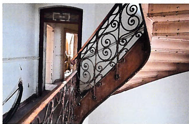
Abb. 35 Erschließungstreppenhaus in der Hochstättenstraße, Sept. 2017
