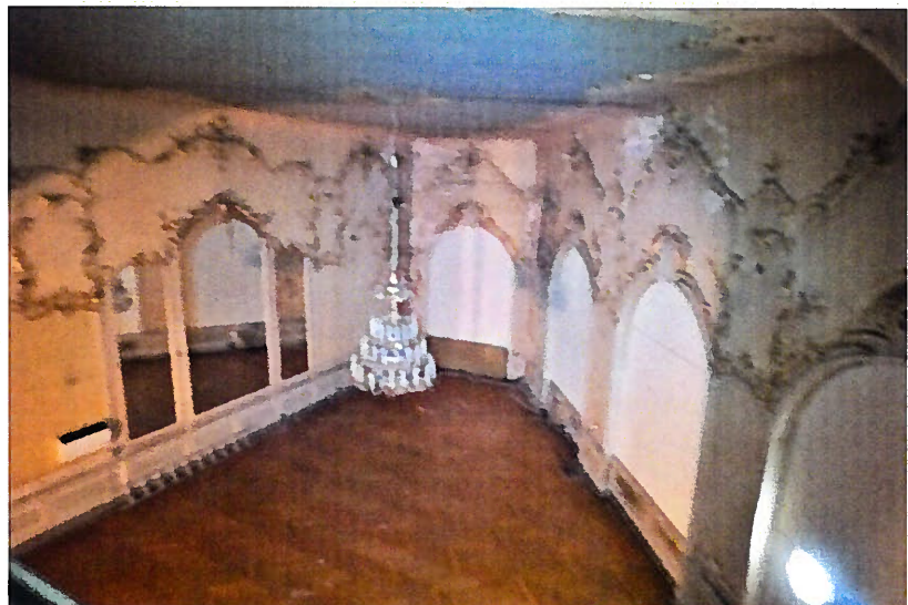
Abb. 13 Blick in das Foyer nach Südosten, Sept. 2017
