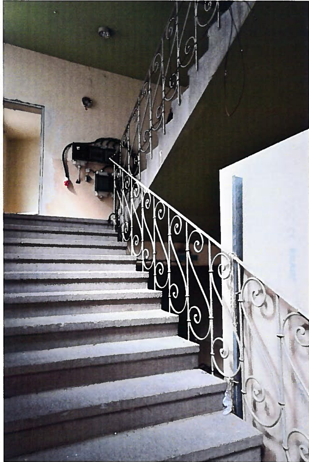
Abb. 38 Fluchttreppenhaus in der Hochstättenstraße, Raum E. 1 B. 42, Sept. 2017
