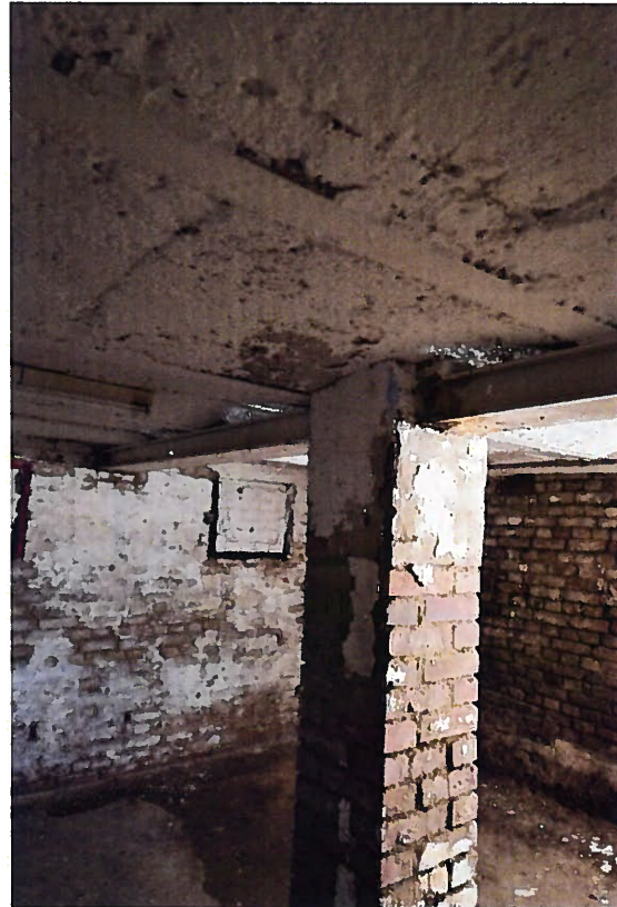
Abb. 42 Raum U2. E.51 Luftschutzraum mit zusätzlichem Ziegelpfeiler und Stahlunterzug, Sept. 2017
