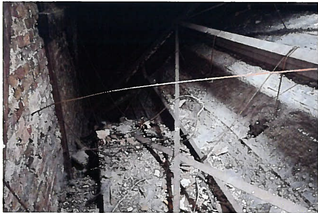
Abb. 59 Dachwerk über dem Festsaal, abgetrennte Abhängungen, Sept 2017
