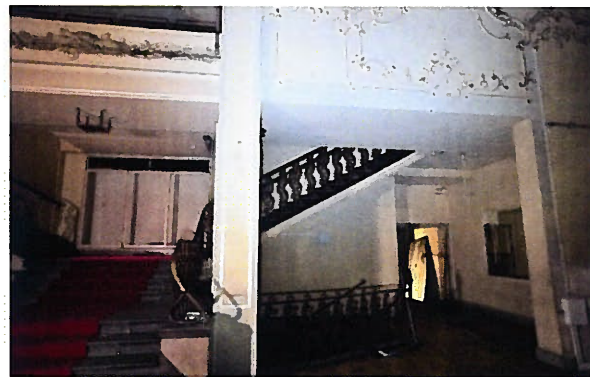
Abb. 30 Foyer, Raum E 1. E10, Richtung Norden, Sept. 2017
