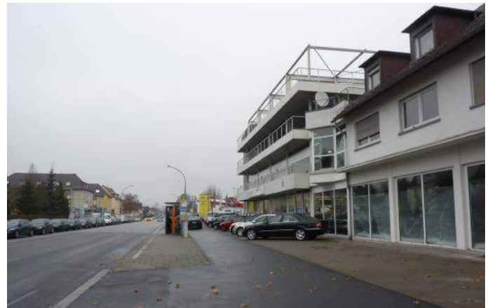
Wiesbadener Straße - Höhe Autohaus Can
