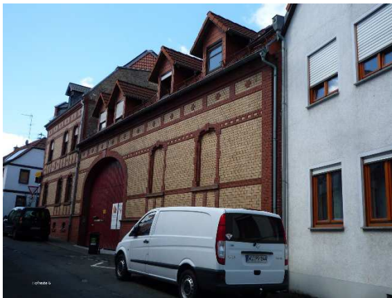
Nebengebäude In der Hofreite 6
