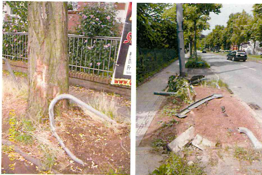
Anfahrtschaden und Totalschaden
